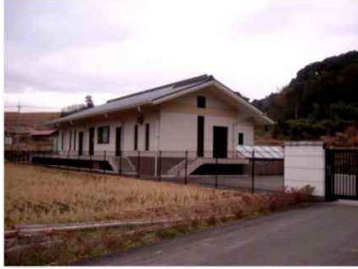
農業集落排水施設の整備
