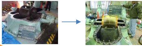
ポンプのオーバーホール(分解整備)
