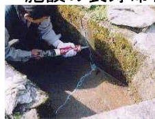
水路のひび割れ補修
