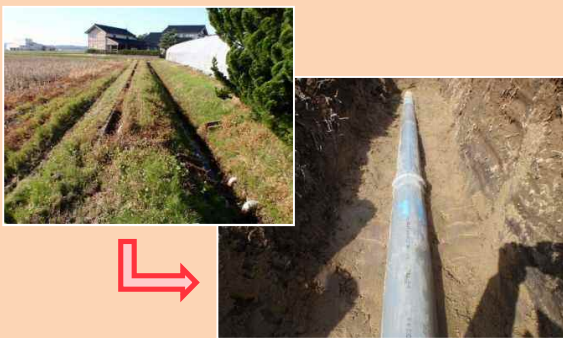
開水路のパイプライン化
