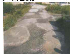
農道の窪みの補修
