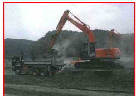
ダムの堆砂除去
