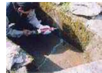
水路のひび割れ補修
