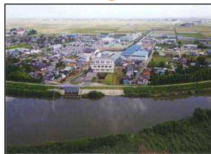
排水機場の改修
