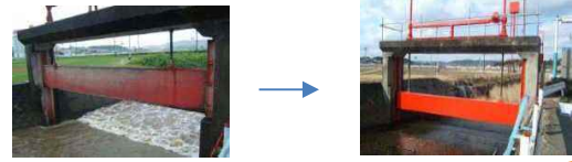
ゲートの塗装
