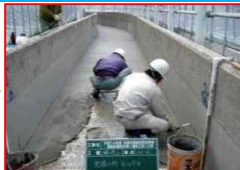
開水路の補修
