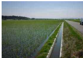
農業用排水路
